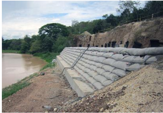
Fotografía 2-2 Ilustración de muro de contención
