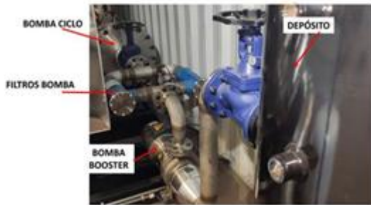
Figura 2-126. Circuito 1, Unidad de Flujo cerrado
