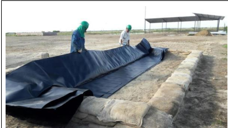
Fotografía 2-6 Dique pruebas auxiliares
