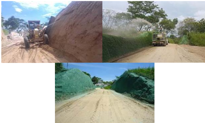
Fotografía 2-1 Revegetalización de taludes
