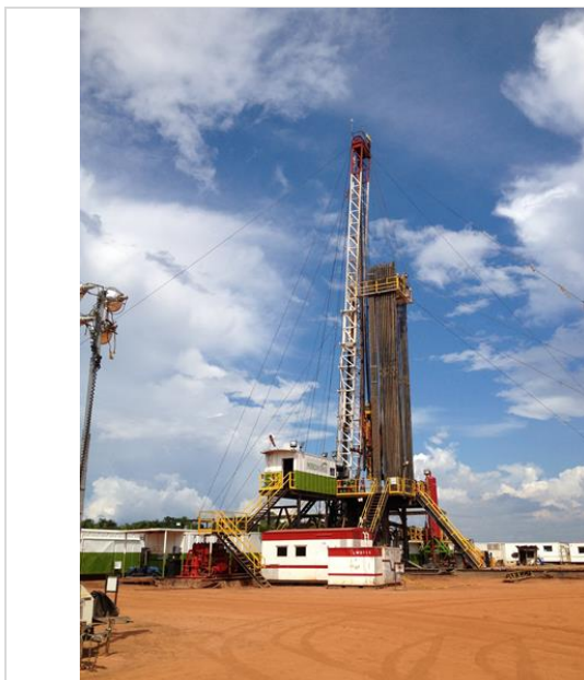
Fotografía 2-7 Taladro de perforación
