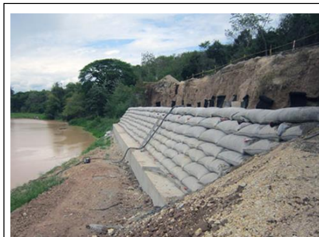
Fotografía 2-4 Muros en gavión
