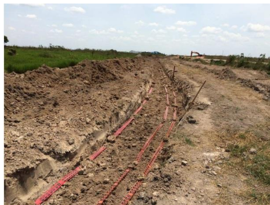
Fotografía 2-18 Instalación de cintas de señalización líneas eléctricas subterráneas
