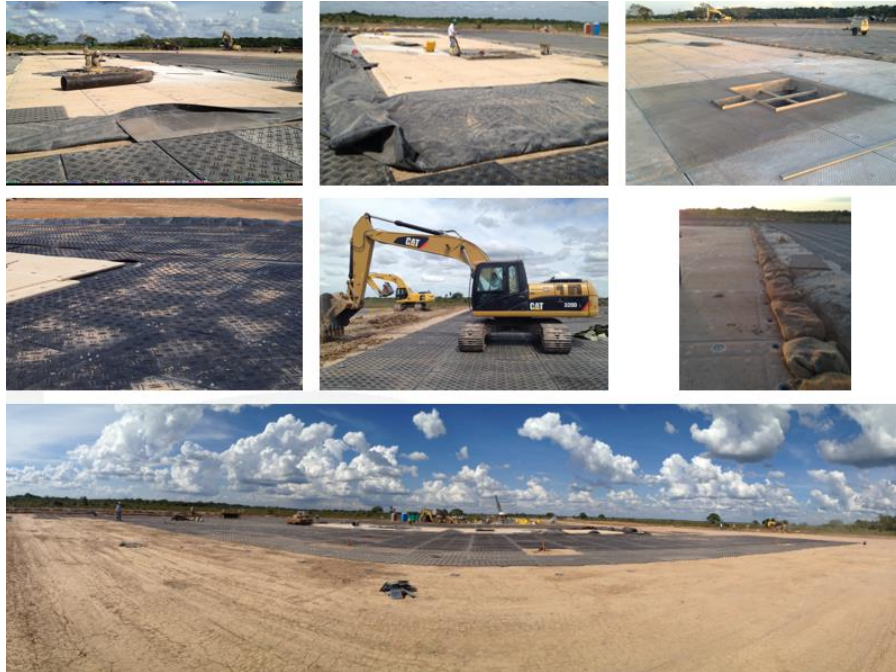
Fotografía 2-3 Superficie modular portátil en polietileno de alta resistencia
