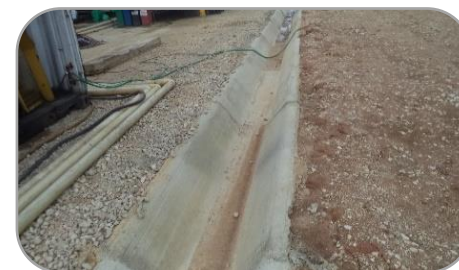
Fotografía 1. Manejo de escorrentía Fuente: PAREX., 2023.
